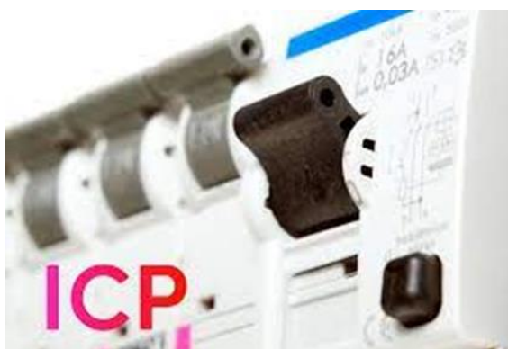
Imagen: Interruptor de control de potencia
