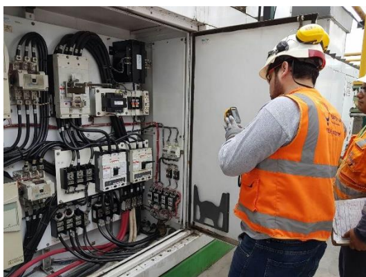
Imagen: Ejecución del mantenimiento de componentes eléctricos
